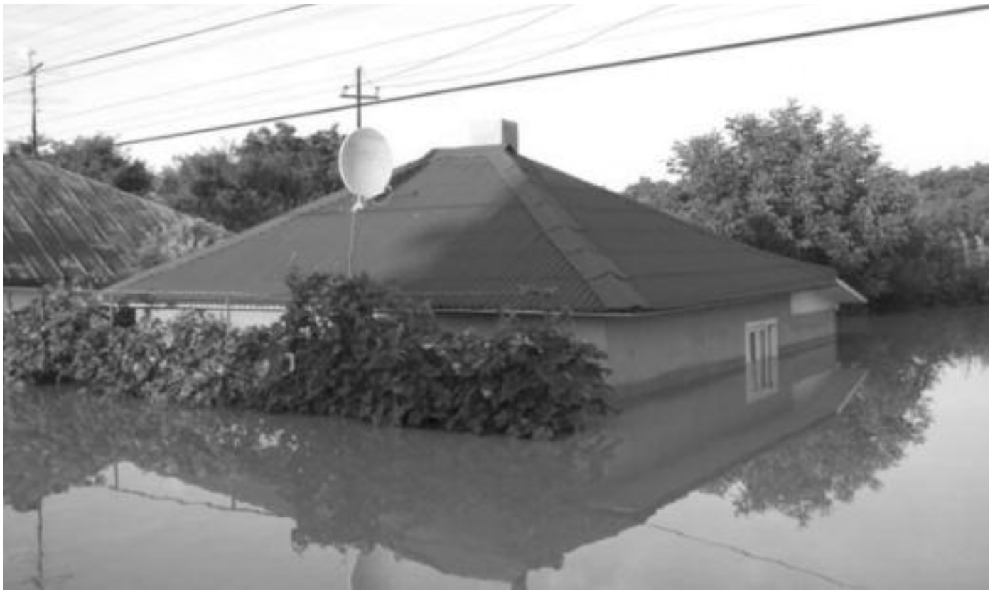
■ Eines der wenigen stabilen Häuser, die das Hochwasser überstanden haben. Es befindet sich im rumänischen Teil der Moldau und kann im Gegensatz zu vielen anderen renoviert werden.
